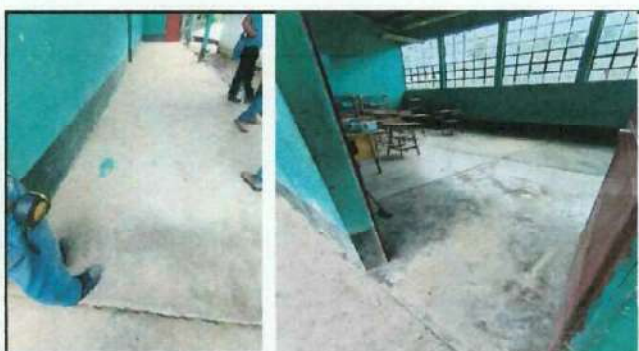
Reemplazo de alisado de torta de cemento por piso cerámico color caoba
